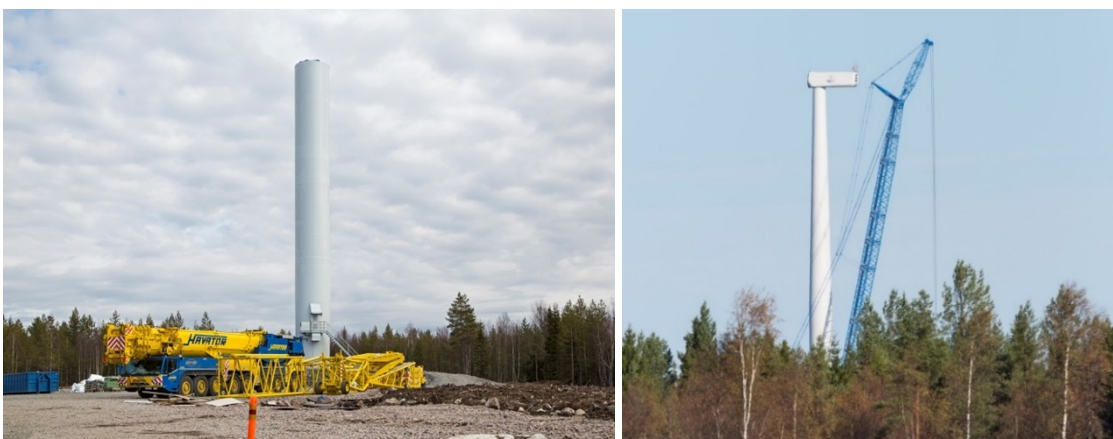
Kuva 26. Tuulivoimalan kokoamista. (Kuvat: FCG)
