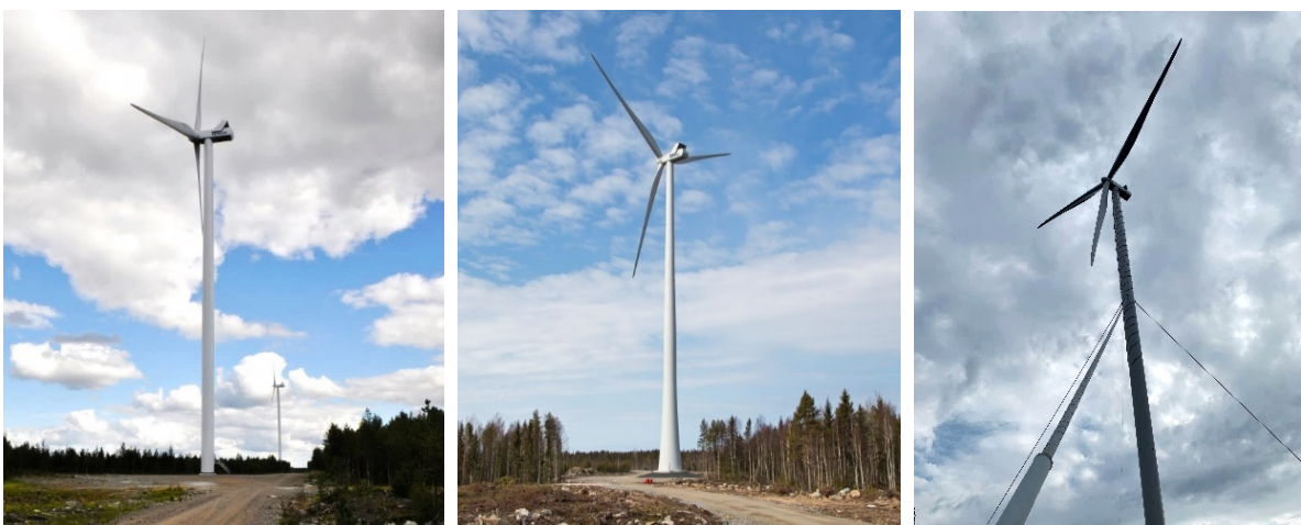
Kuva 17. Vasemmalla on esimerkki teräslieriötornista, keskellä hybriditornista ja oikealla harustetusta tornista. 250 metrin korkeuden ylittäminen ei välttämättä tarkoita harustettua tornia. (Kuvat: FCG sekä Jarkko Finnilä, Carelin)
