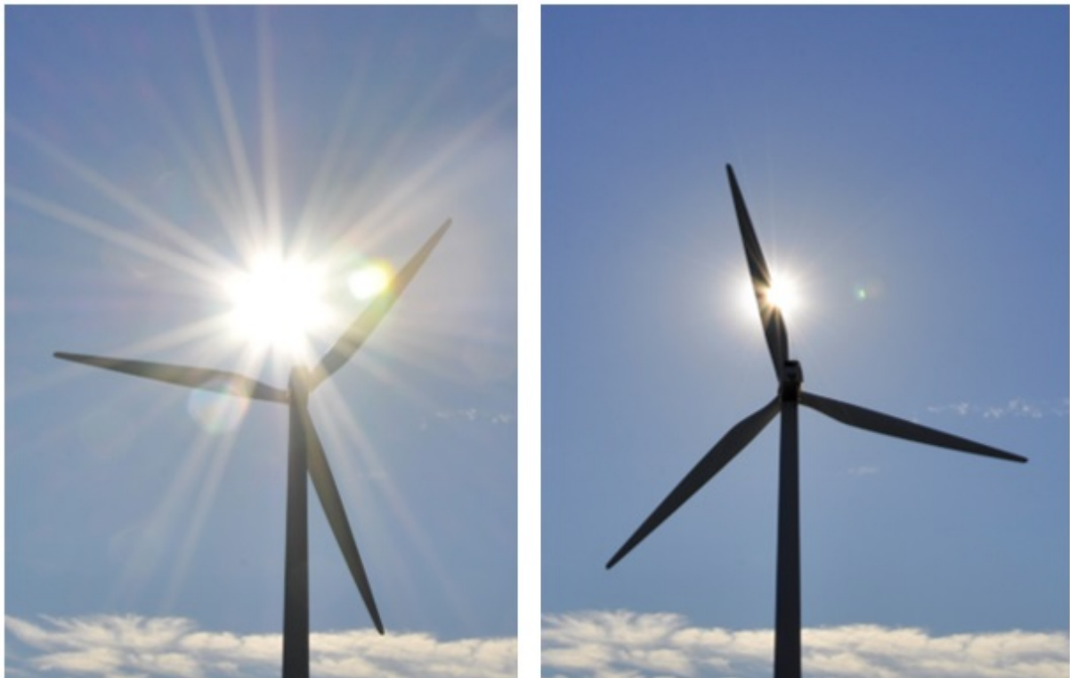
Kuva 152. Tuulivoimaloiden lavat aiheuttavat pyöriessään vilkkumista ja varjon välkkymistä aurinkoisella säällä.
