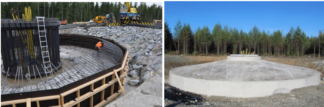
Kuva 25. Tuulivoimalan perustusten rakentamista. (Kuvat: Leila Väyrynen, FCG)
