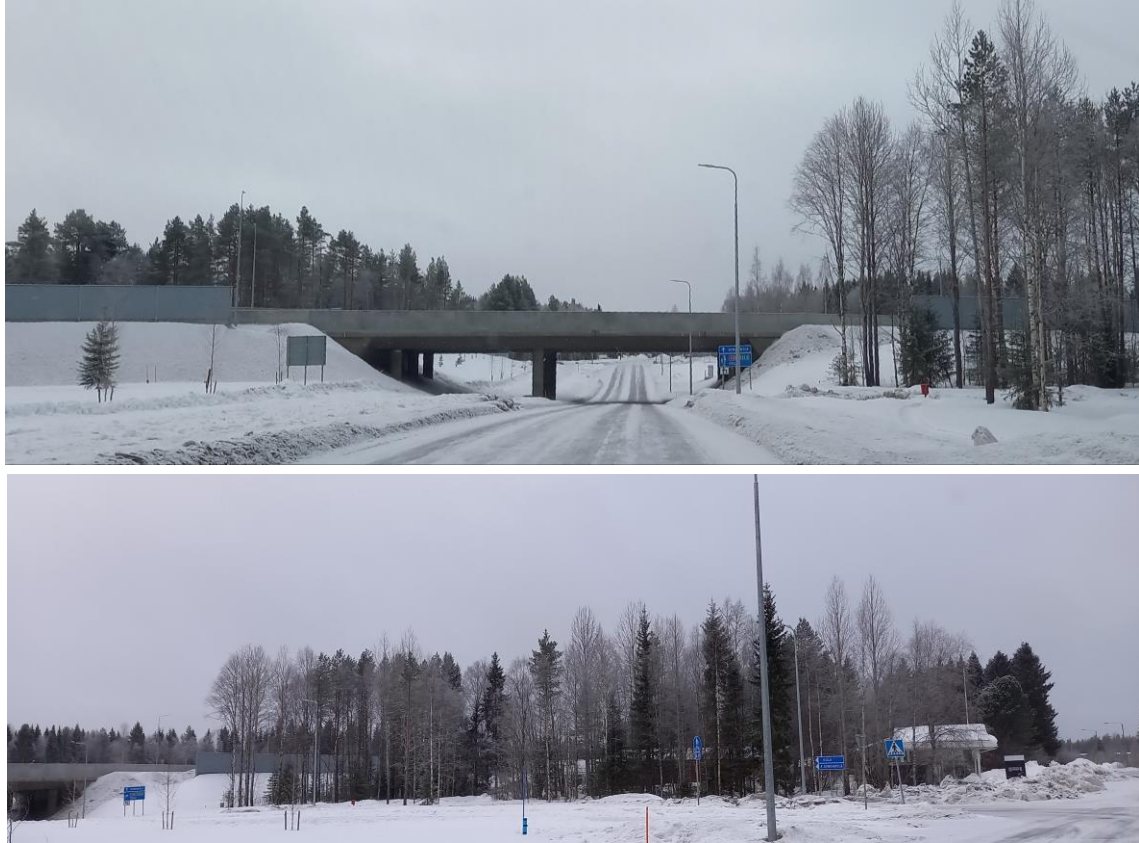
Kuvat 14 ja 15. Ylemmässä kuvassa nähdään toteutetut meluseinät E4-tielle ja alemmassa kuvassa kaavamuutosalue suhteessa E4-tiehen.
