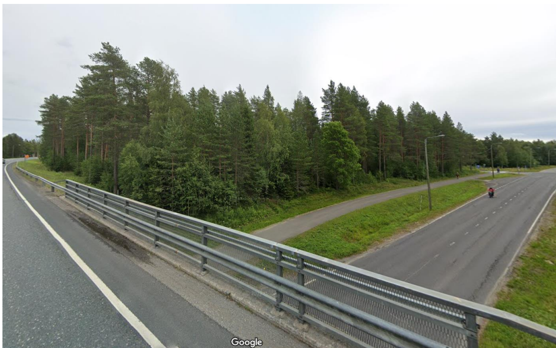
Kuva 2. Kuva alueesta heinäkuulta 2021: Näkymä Vt 4:lta suunnittelualueen suuntaan. Nykyisellään Vt 4:n reunaan on sijoitettu melusuojat. © Google Maps
