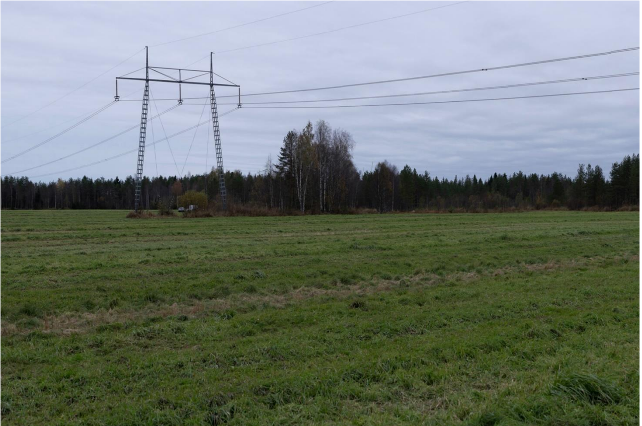
Kuva 10.19 Havainnekuva Levälän pohjoispuolelta kohti etelälounasta, (Kuva 10.4, kohde 8). Kuva vastaa 50 mm objektiivia. Etäisyys lähimpään voimalaan noin 6 km. Viiden voimalan lapoja näkyy osittain puuston takaa. Kuvauspisteessä voimalat muuttavat maisemaa vähäisesti.
