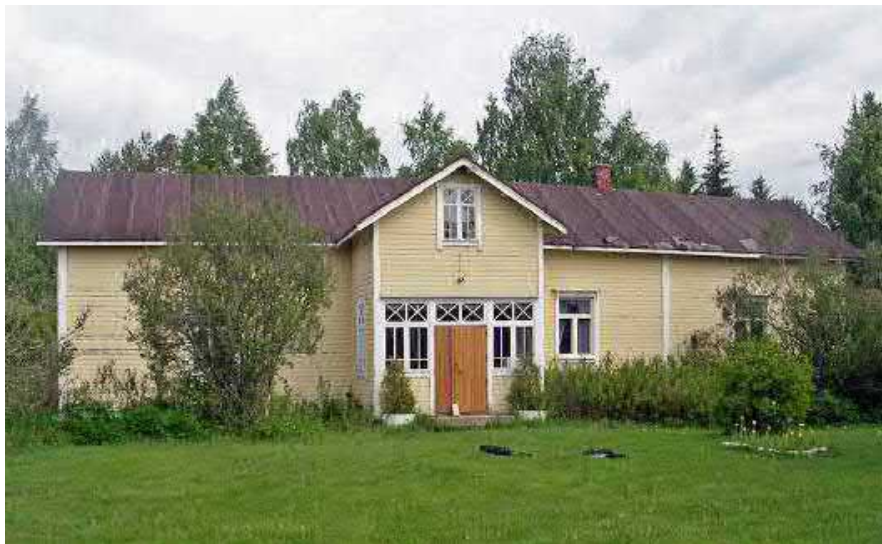
Kuva 33. Lehtolan päärakennus (Kuva LKYT 2006).
