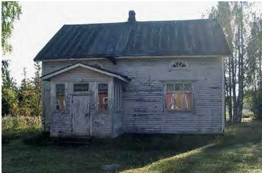
Kuva 14. Lehtolan päärakennus (Kuva LKYT 2006).
