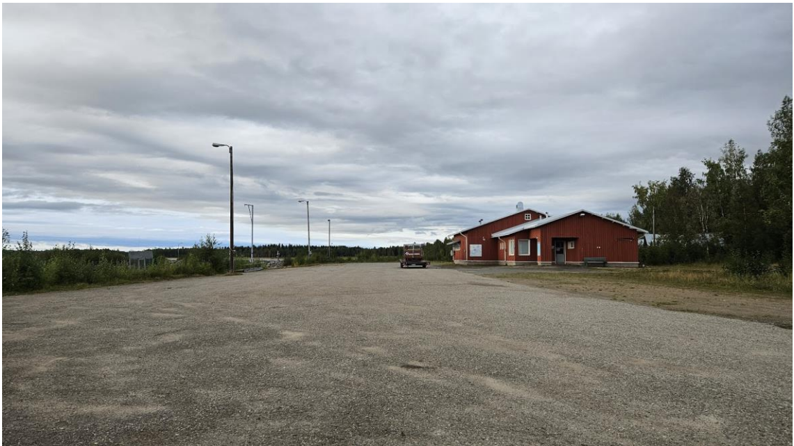
Kuva 4. Suunnittelalueen pohjoisosassa sijaitsevan venesataman/-valkaman alue ja sen huoltorakennus.
