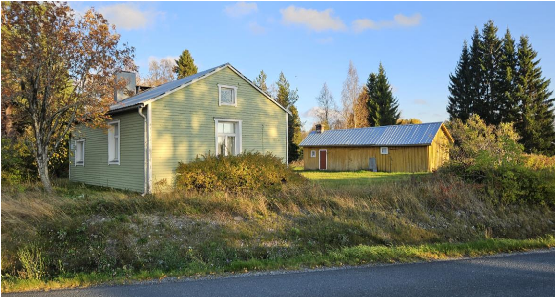
Kuva 15. Sänkeläntie 2 a. Pihapiirin vanhimpia rakennuksia.
