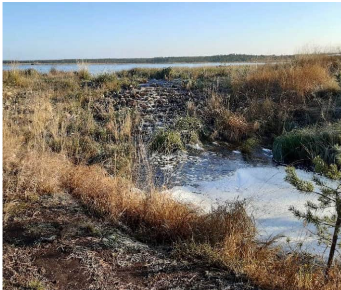
Kuva3. Pohjakynnyks padottaa kosteikon veden.
