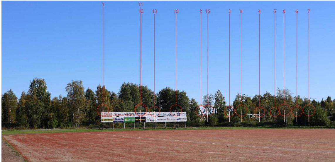
Kuva 10-15. Havainnekuva (nro 4) ja "rautalankamalli" kaavaratkaisun mukaisista tuulivoimaloista. Voimalat on tuotu valokuvan päälle niiden sijainnin havainnollistamiseksi. Tuulivoimaloista ei näkemäesteiden vuoksi näy kuvauspaikkaan kuin korkeintaan lavan osia tiheän kasvillisuuden raoista. Kuvauspaikka on Simon keskustassa, Lanssitiellä, Simon urheilukentällä – n. 8,1 kilometrin etäisyydellä lähimmästä suunnitellusta tuulivoimalasta lounaaseen.
