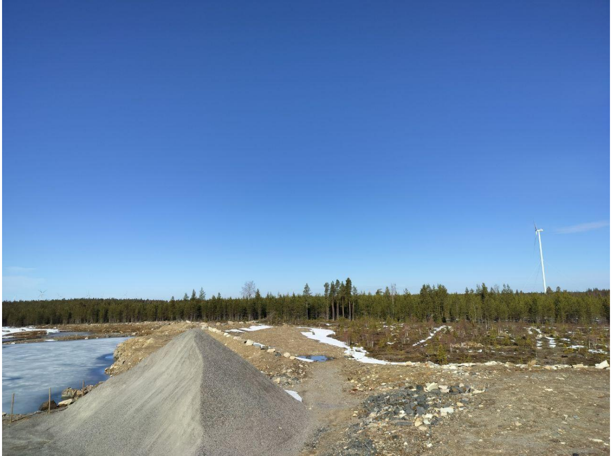
Kuva 4-4. Näkymä murskekasan päältä pohjoiseen tuulivoimaloiden hankealueen suuntaan, kuvattuna kevätmuuton seurannan aikaan. Syysmuuton aikaan erityisesti pohjoinen ja koillinen ovat tärkeimmät tarkkailusuunnat.
