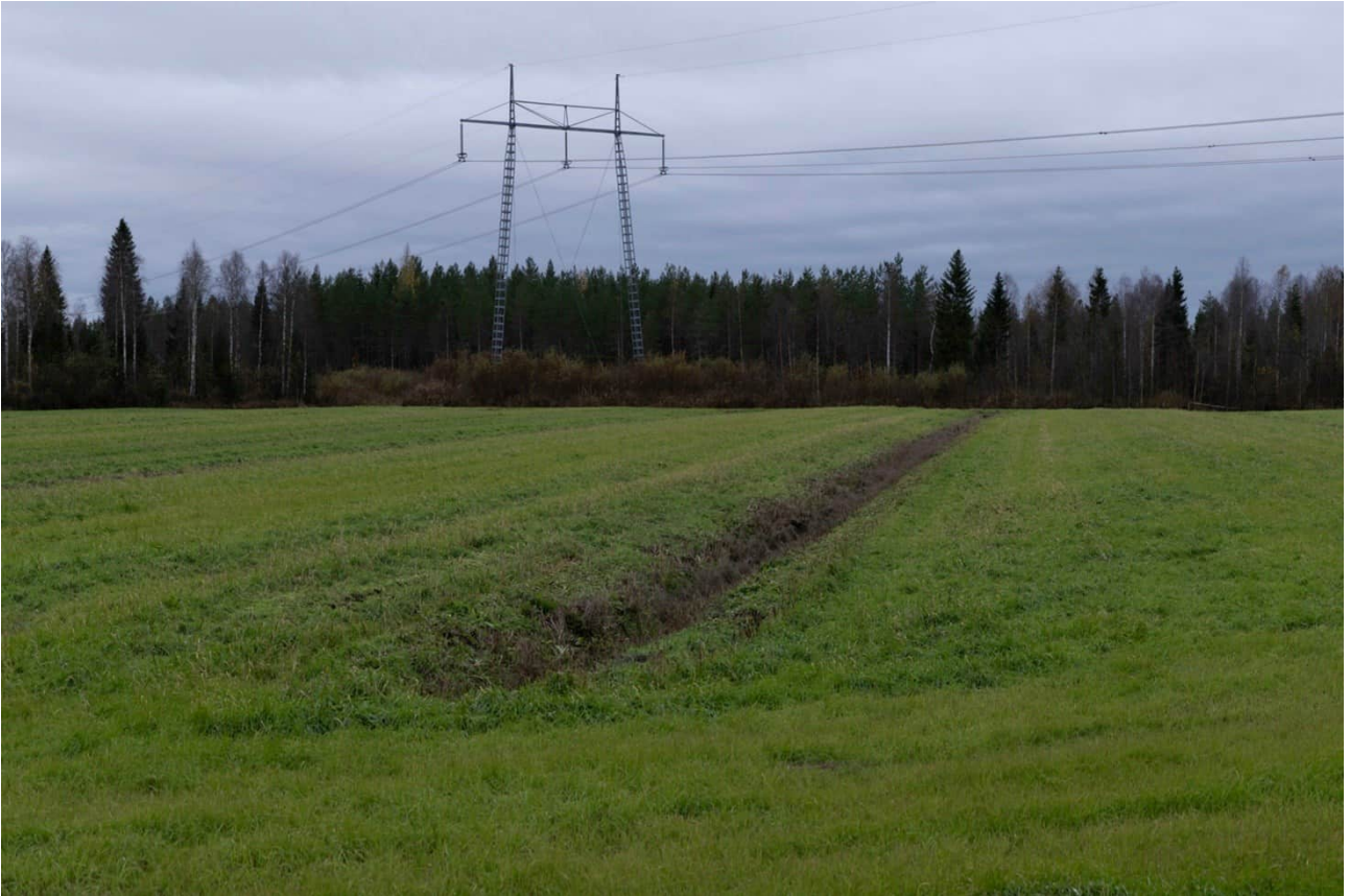
Kuva 10.22 Havainnekuva Levälän länsipuolelta (edellistä kuvaa idempää) kohti etelälounasta, (Kuva 10.9, kohde 7). Kuva vastaa 50 mm objektiivia. Etäisyys lähimpään voimalaan noin 5,5 km. Voimalat eivät erotu metsän takaa. Voimaloilla ei ole maisemavaikutusta tässä kuvauspisteessä. Kuva: Rawhide Productions.
