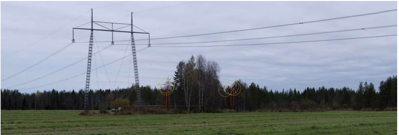
Kuva 10.25 Havainnekuva Levälän pohjoispuolelta kohti etelälounasta. Valokuvan päälle on lisätty voimaloiden tornit punaisella ja lapojen pyörimisalue keltaisilla ympyröillä. Kuva: Rawhide Productions.
